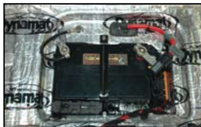
Après démontage des garnitures et insonorisation dans les règles de l'art, la batterie d'origine est remplacée par une Shuriken plus puissante.
